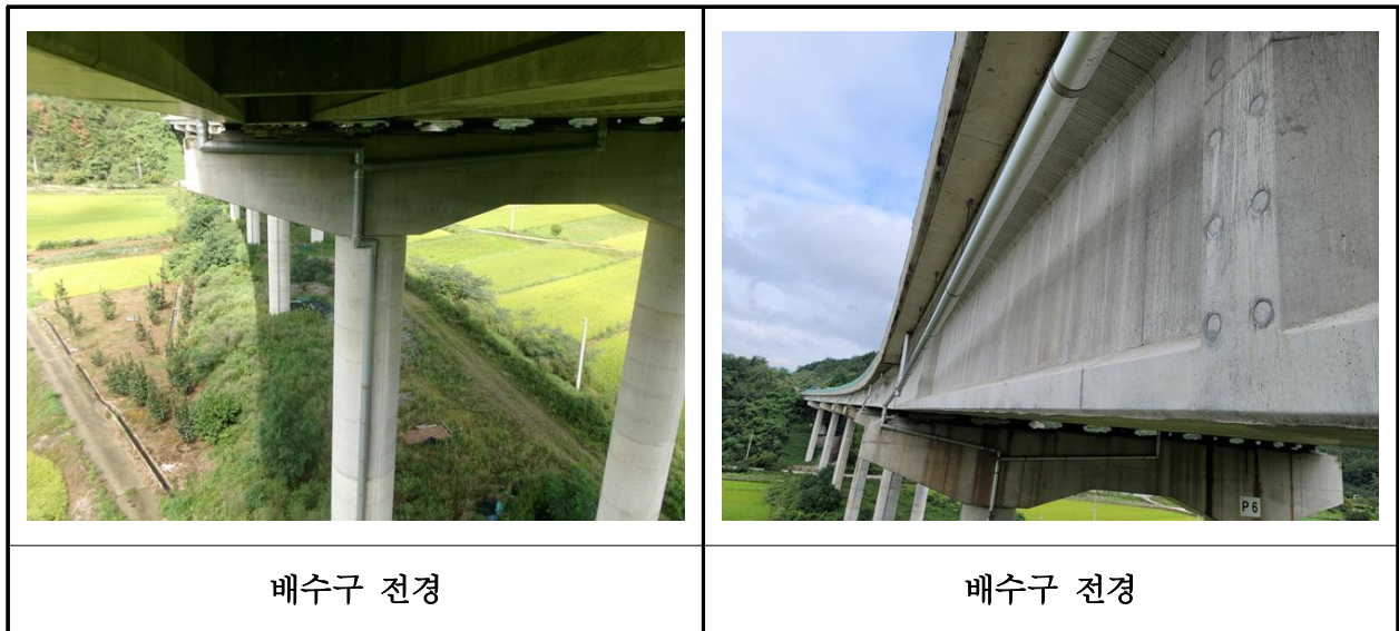
【사진 8.3.22】 배수시설 전경
