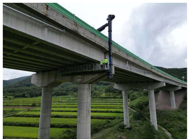
부재 현장측정 전경
