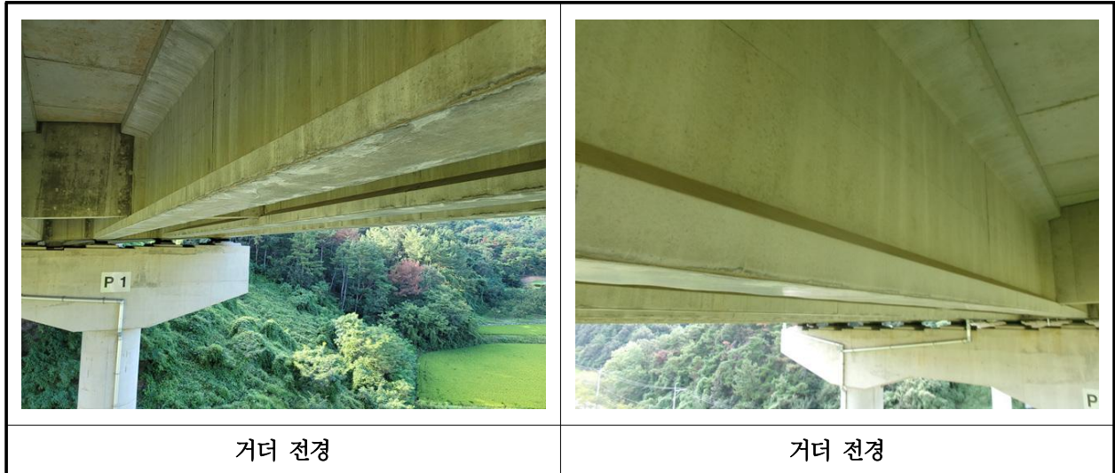
【사진 8.3.4】 거더 전경
