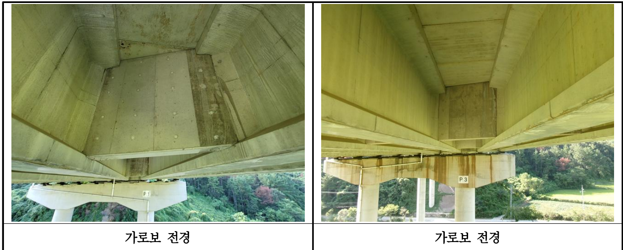
【사진 8.3.6】 가로보 전경
