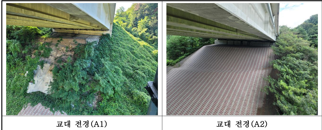
【사진 8.3.8】 교대 전경
